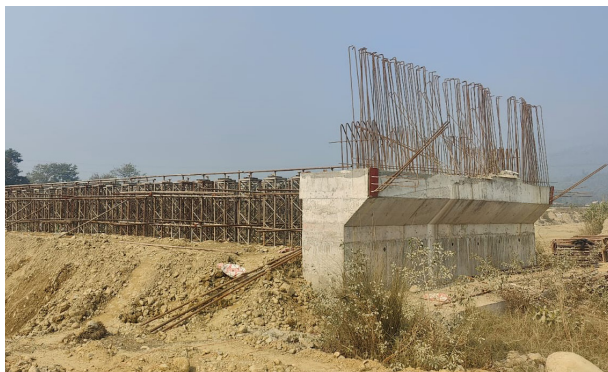
खजुरा खोलामा निर्मानाधिन पुल
